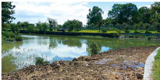
改造前杂草丛生，高潮位仍有大面积边坡裸露（上）
