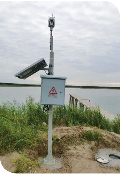
完成条子泥 720 自动化水质水文气象设备的安装与调试
