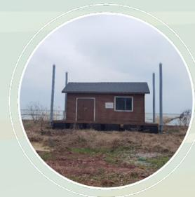
那么如何避免重要的监测设备设施被水淹以及减少运输成本呢？这个监测站就是应对这种特殊环境建造出来的。涨水时，监测站浮起，四周铁杆与底座设置有滑轮，穿插固定，防止监测站随水流漂走。等四周完全被水淹没，湖面只剩这孤独的木房子，等待着监测人员下一次的到来。
